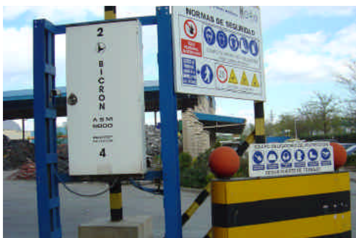
Arcos detectores de radioactividad a la entrada de las instalaciones
