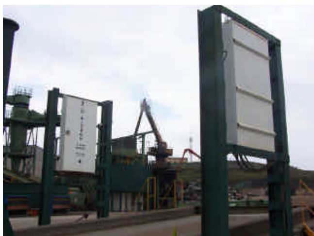
Arcos detectores de radioactividad a la entrada de las instalaciones
